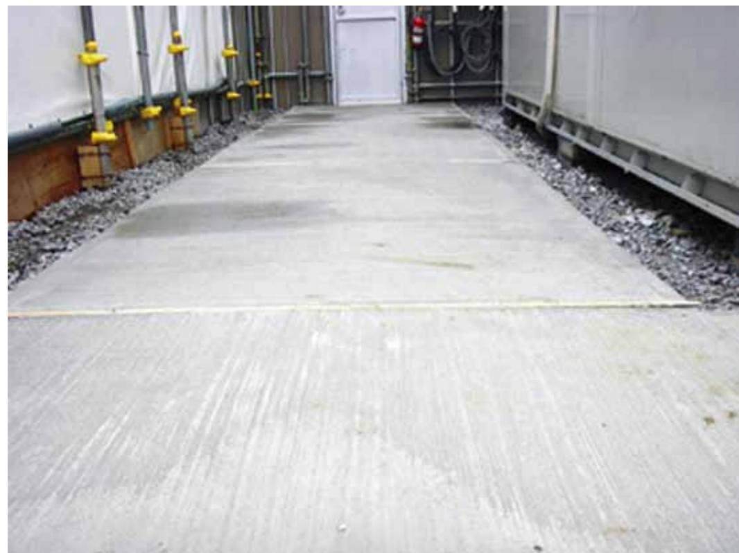
千葉マンション現場
